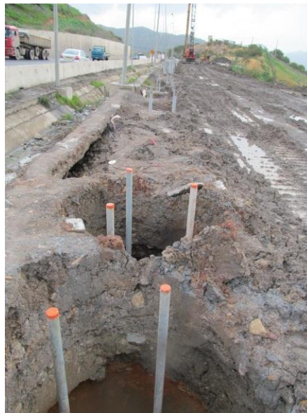
Figure 3.2 Ligne de pieux (tronçon Buira-Alger, Mars 2014).
