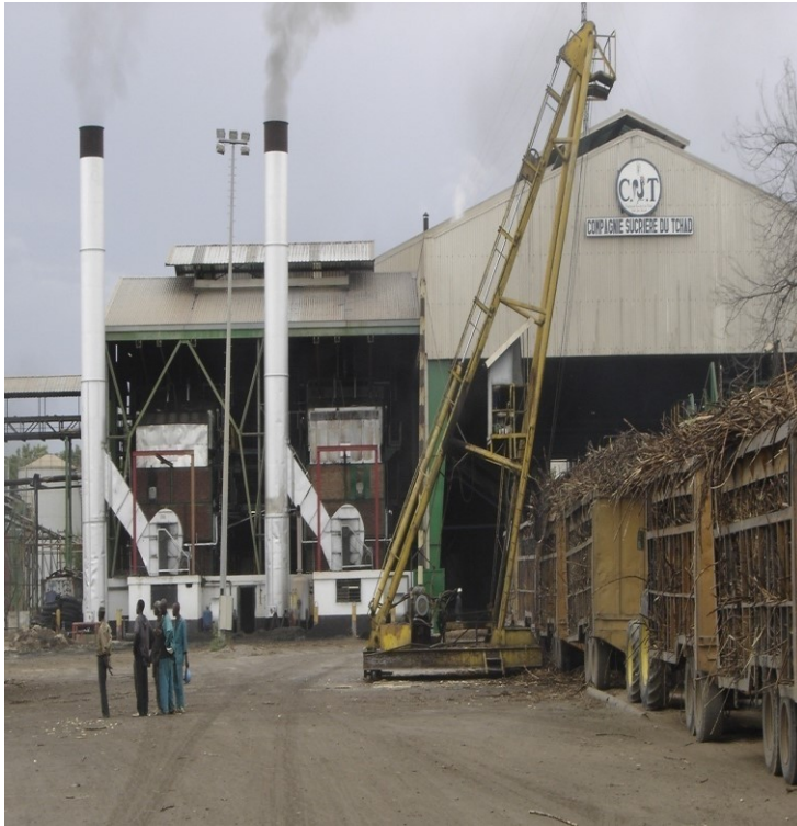
Photo 2 : Complexe Agro-industriel (département usine) de Banda/Sarh
